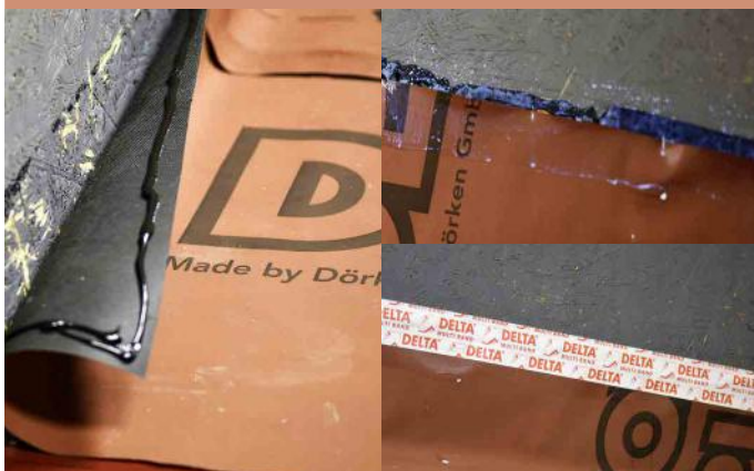
Detail napojenia fólie
